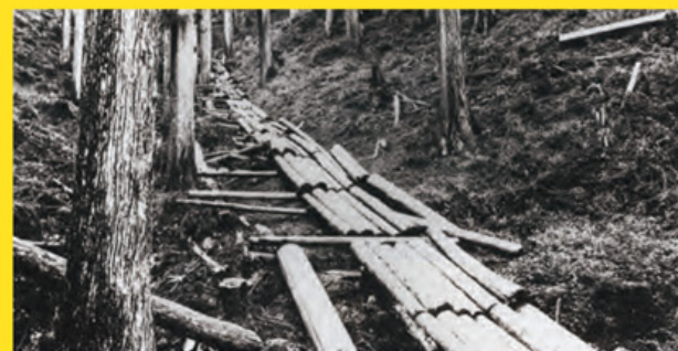
川上村 神の谷の木馬出しの様子(写真:「吉野山林写真帳」より)
