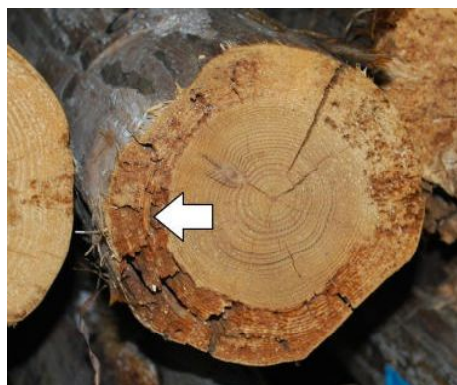
図 II-4 ヒノキ辺材部の腐朽の様子
